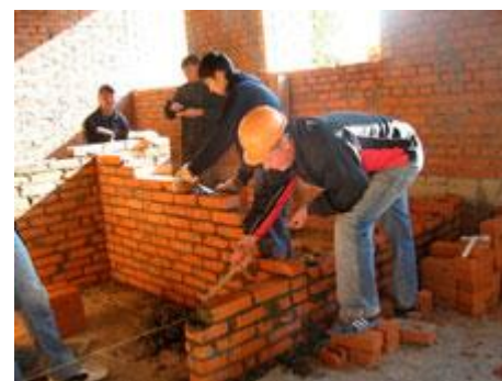
Производственная практика на строительном объекте ЗАО «ПМК-3»
